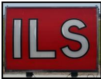
ILS Hold Position Sign
